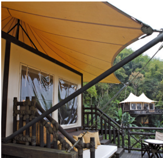
Fermetures de terrasse
